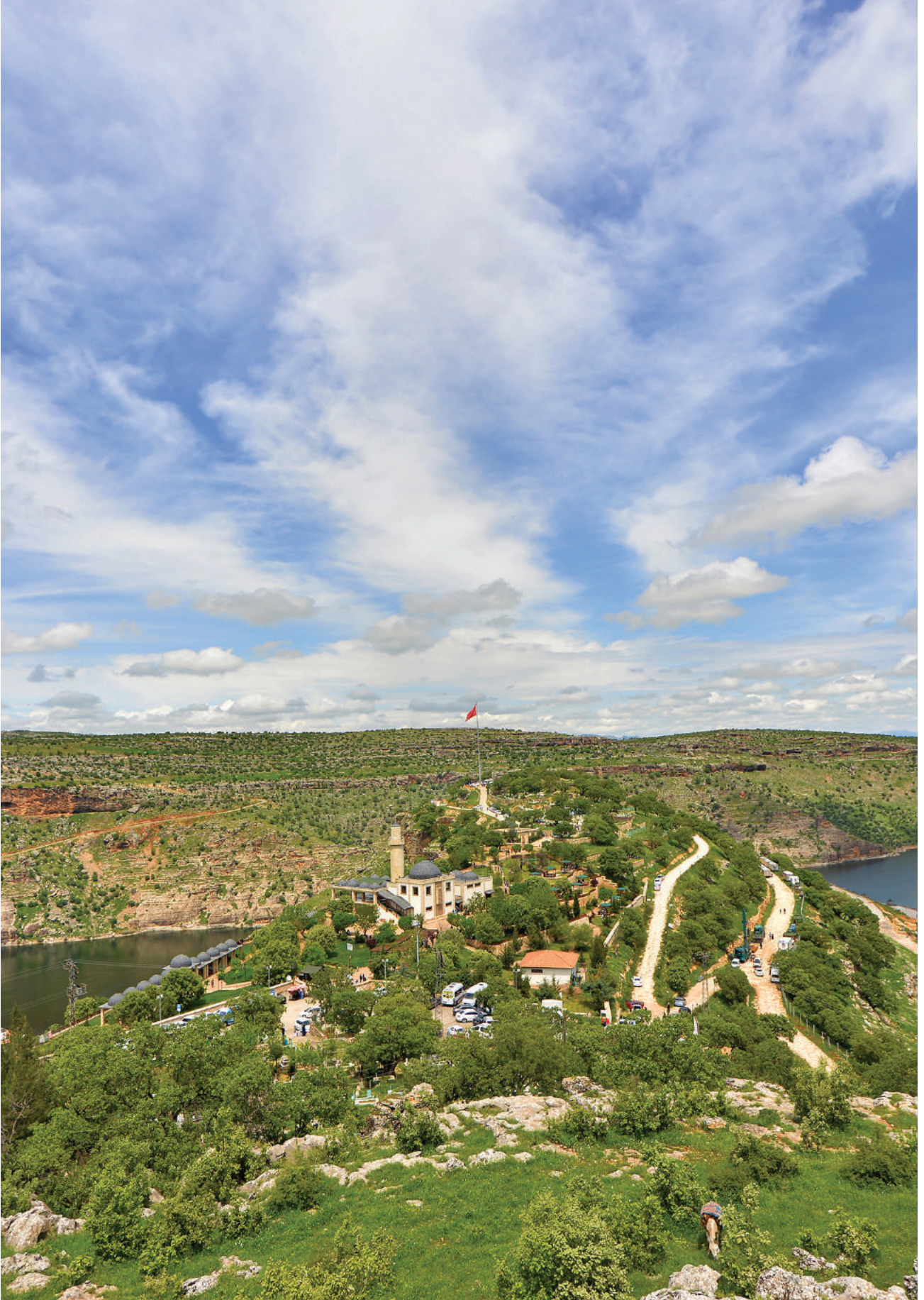
Eğil, Peygamberler Türbesi ve Dicle Barajı Genel Görünüm
