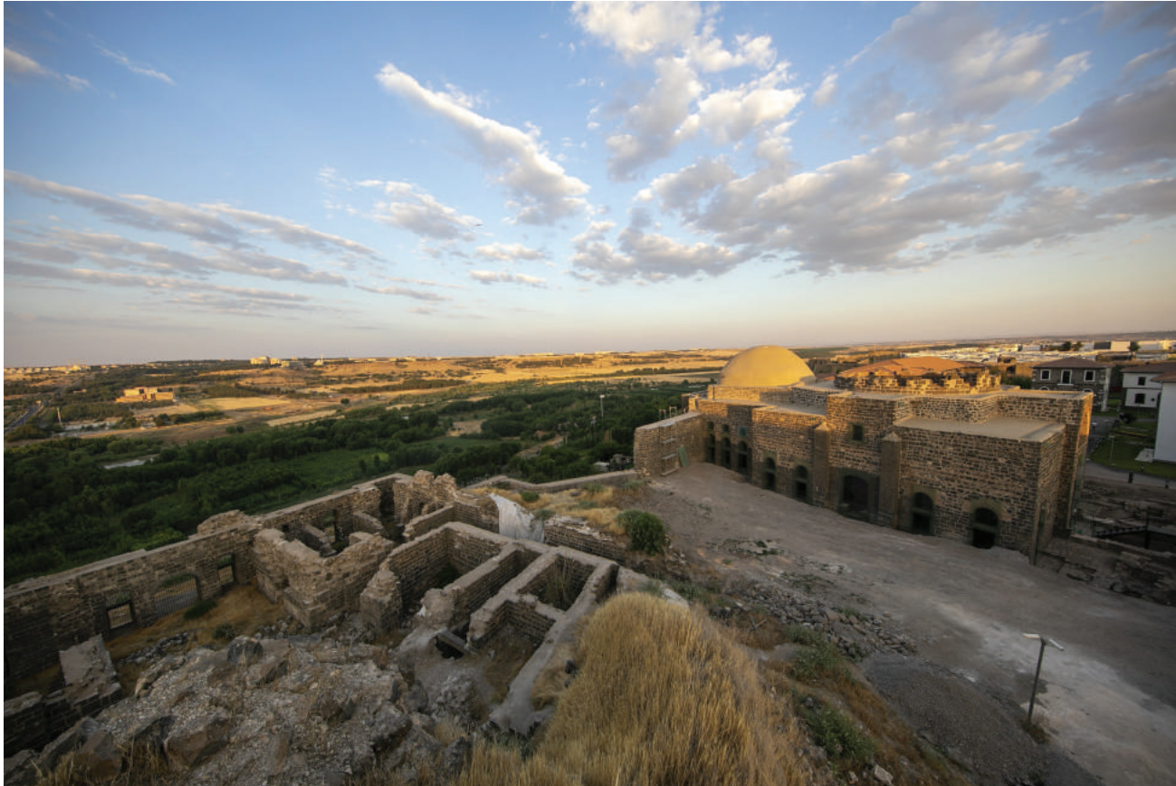
Eski Saray Kalıntısı ve Saint George Kilisesi Genel Görünüm-İç Kale-Sur
