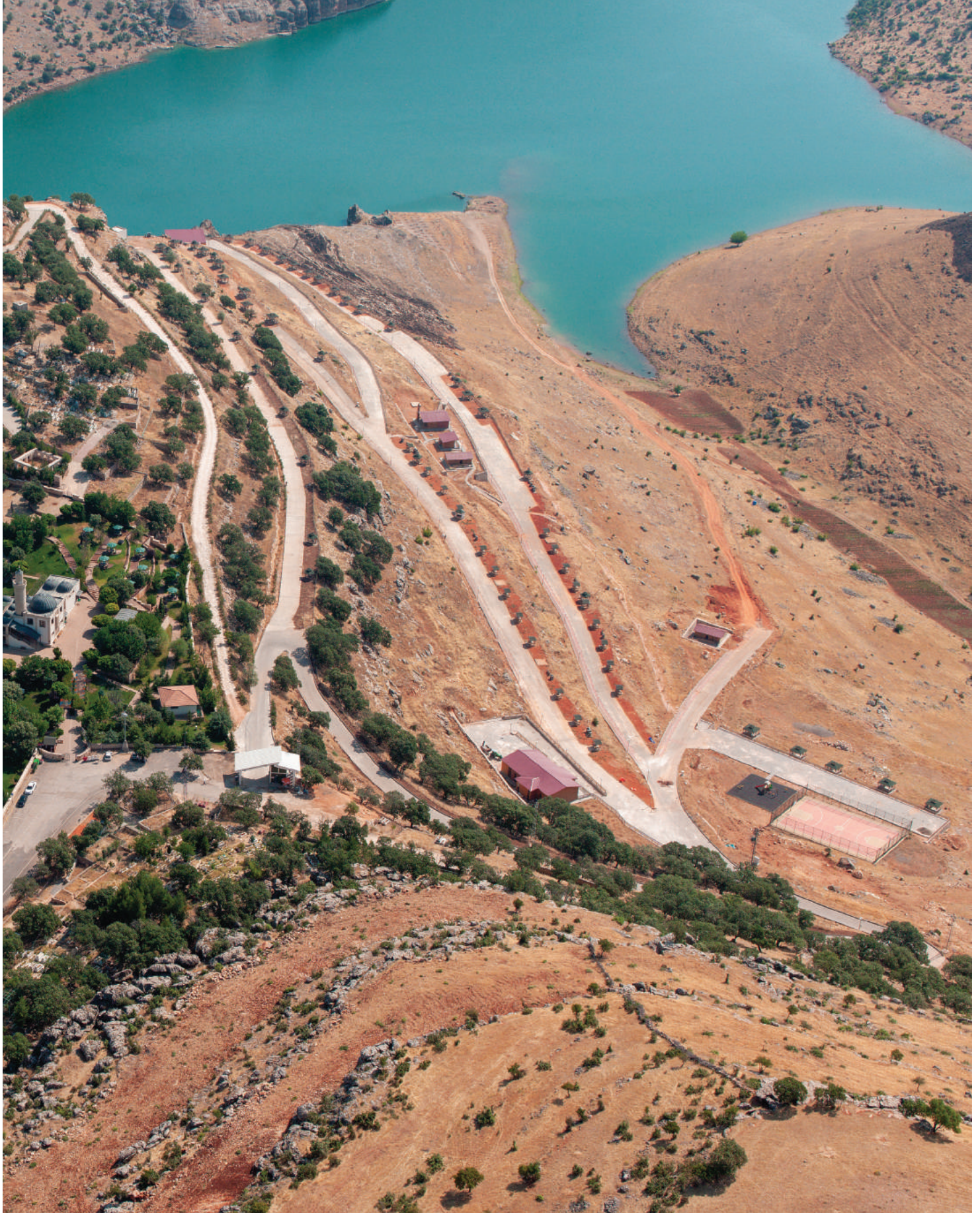
Eğil, Peygamberler Türbesi ve Dicle Barajı Genel Görünüm
